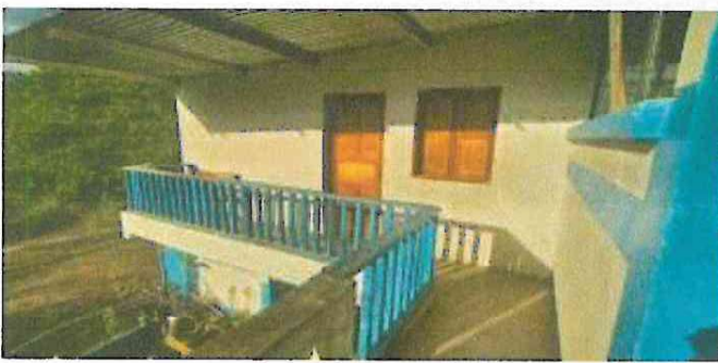
Foto 3: Sustitución de puerta de madera por metal en cocina, sustitución de ventanas de madera por metal en cocina, sustitución de barandas de madera por metal en pasillo.
